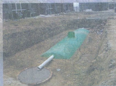
北京奥运山地车赛场 单体50T施工现场
